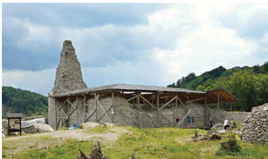
Obr. 4. Pohľad na vežu Dolného hradu po výskume a obnove v roku 2016. Foto: Ján Beljak.
